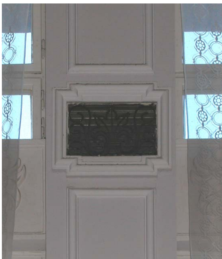
Ostrov, nové město - Dům kultury, předsálí – detail ventilačního systému v pilastrech, č. neg. 00223.
